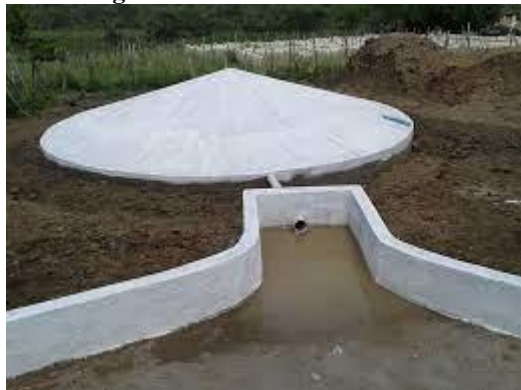
Figura 2: Cisterna de enxurrada 5
