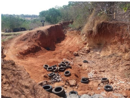
Figura 9a. Criação de estrada de acesso ao local.
