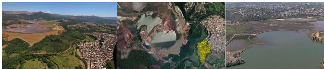
Figura 16 – Esquerda: Barragem urbana de Casa de Pedra. Fonte: Oliveira, 2019.
