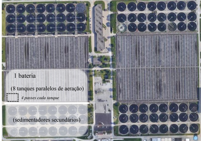
Figura 1: As quatro baterias paralelas do processo de lodos ativados da SWRP.
