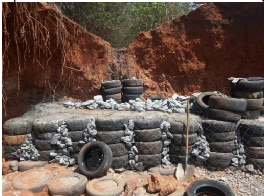
Figura 10a. Escada para redução da energia cinética da água feita com pneus usados e restos de materiais de construção civil.
