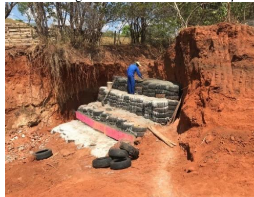
Figura 10b. Escada para redução da energia cinética da água em fase final de construção.
