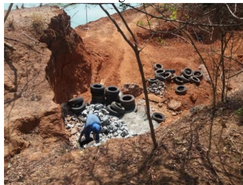
Figura 9b. Início do processo de construção da escada para redução da energia cinética da água.
